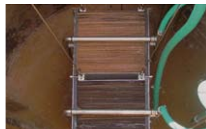
Die plattenförmigen Membranen sind parallel angeordnet.
