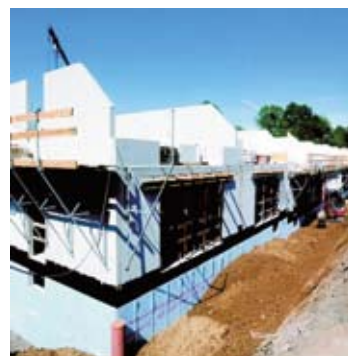
Reihenhausrohbau aus Kalksandsteinen
