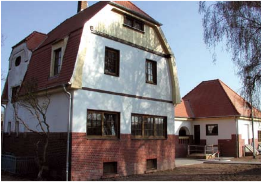
Das Bildungs- und Informationszentrum für dezentrale Abwasserbehandlung in Leipzig
