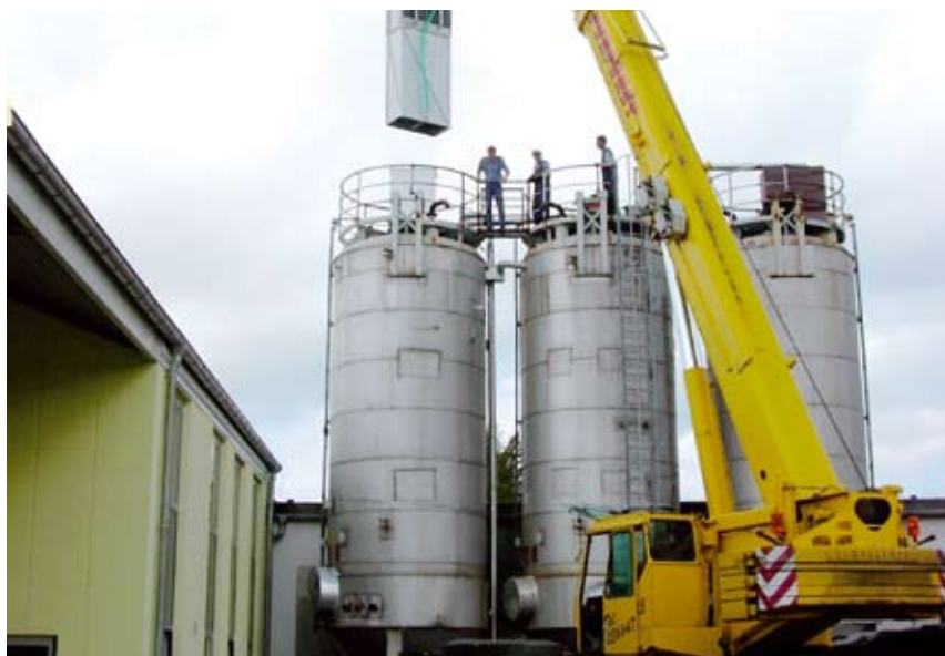
Die A3 Water Solutions GmbH baut Membrananlagen zur Abwasserbehandlung.
