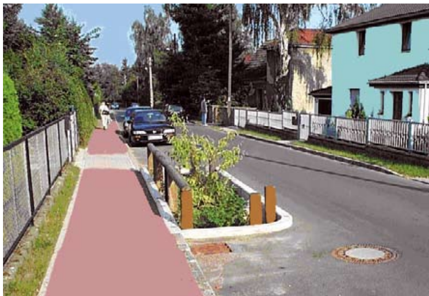
Beispiel für eine dezentrale Regenwasserversickerung im Stadtgebiet
