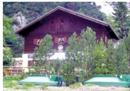
Die Wimbachgrieshütte – im Vordergrund die Kammern der neuen Kläranlage
