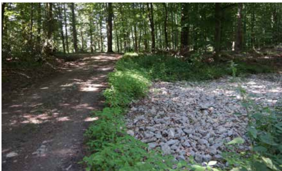
Abb. 22 Besonders in den Einfahrtsbereichen von Rückegassen bilden sich oftmals geeignete Kleinstgewässer. Eine permanente Befestigung durch Einbringung von Schroppen und anderen Materialien sollte in Gelbbauchunkegebieten nur an äußerst kritischen und sehr nassen Bereichen erfolgen.
